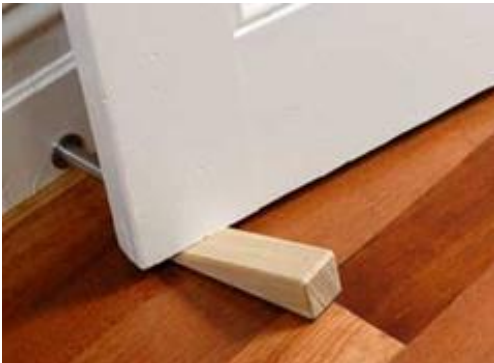
Fig. 5.32. Vendosja e pykës për të mbajtur peshën e derës në nivelin e dëshiruar.
