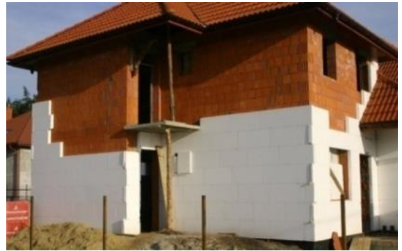
Fig. 6.28. Izolimi termik i shtëpisë me stiropor.
