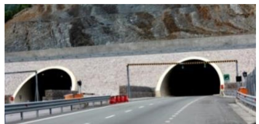
Fig. 3.12. Tuneli i Kalimashit.
